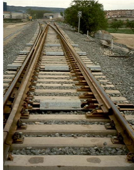
Foto 8. Desvío instalado en Tardienta.
