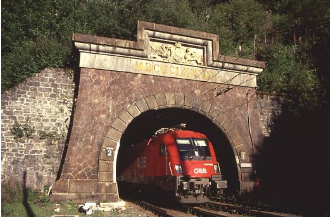
Locomotora de los ferrocarriles austríacos saliendo de un túnel del Arlbergbahn
