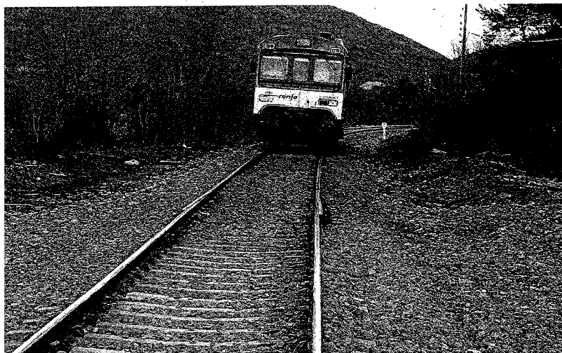
UN SALTO DE 90 AÑOS. Un tren Tamagochi abandonaba el martes el apeadero de Anzánigo, donde se aprecian las nuevas traviesas de hormigón (en primer plano) y las de madera instaladas en los años 20 del siglo pasado. Este viejo material se mantiene en los 89 kilómetros pendientes de renovación entre Huesca y Canfranc. RAFAEL GOBANTES
