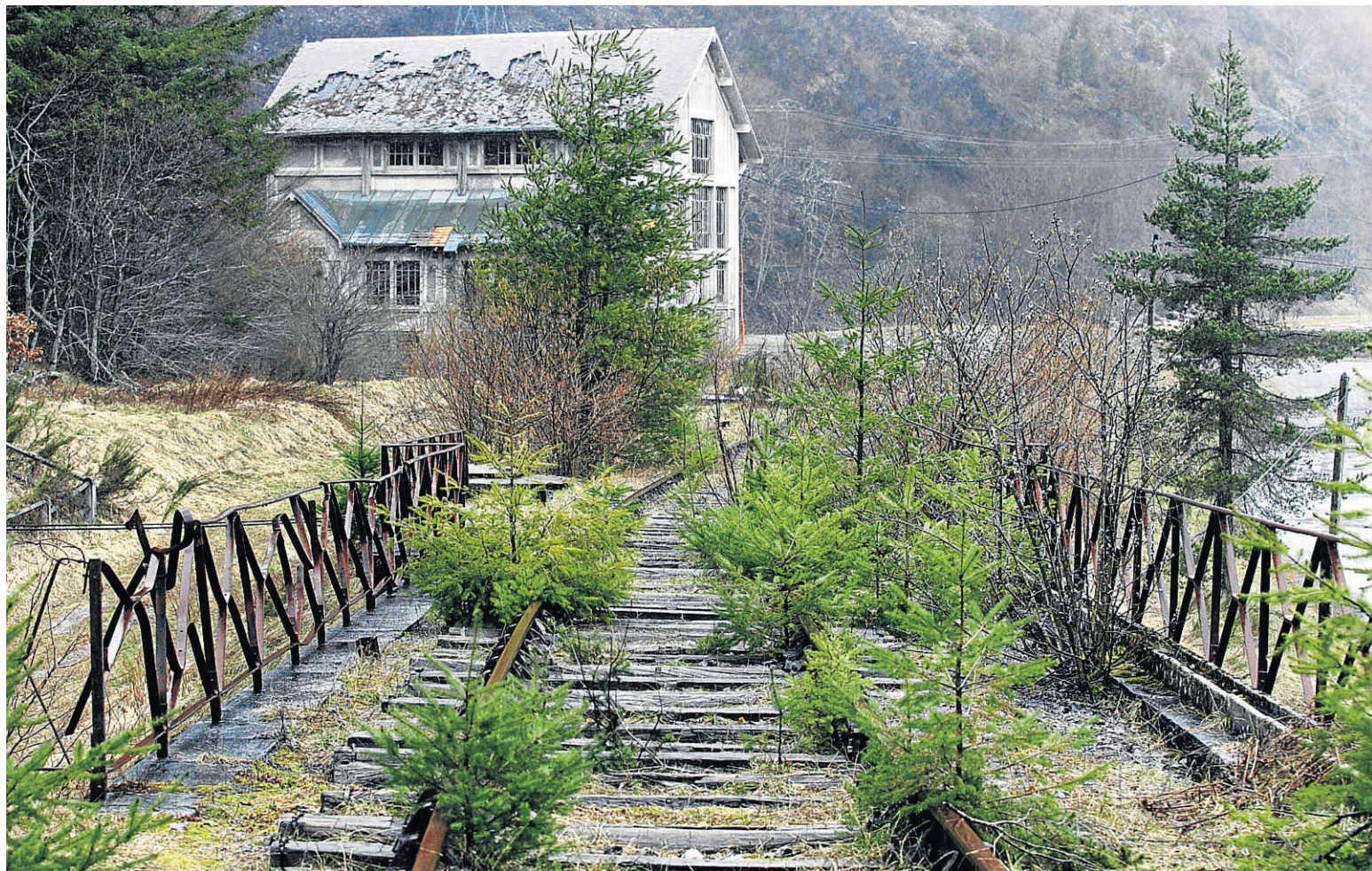
Estado de la vía, junto a la boca francesa del túnel y con la estación de Forges d'Abel al fondo, la semana pasada. JAVIER BLASCO
