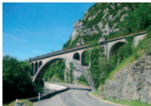
Viaducto de Escot, en el valle de Aspe
